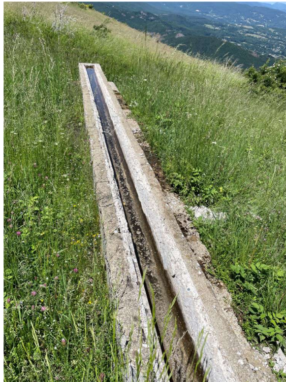
Figura 18 – Abbeveratoio esistente in calcestruzzo (quota 1453 m; a nord est di loc. Buca del Sassone)
