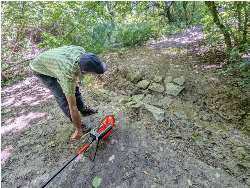
Foto 13 – Progressiva 300,0m attraversamento con basto in pietra
