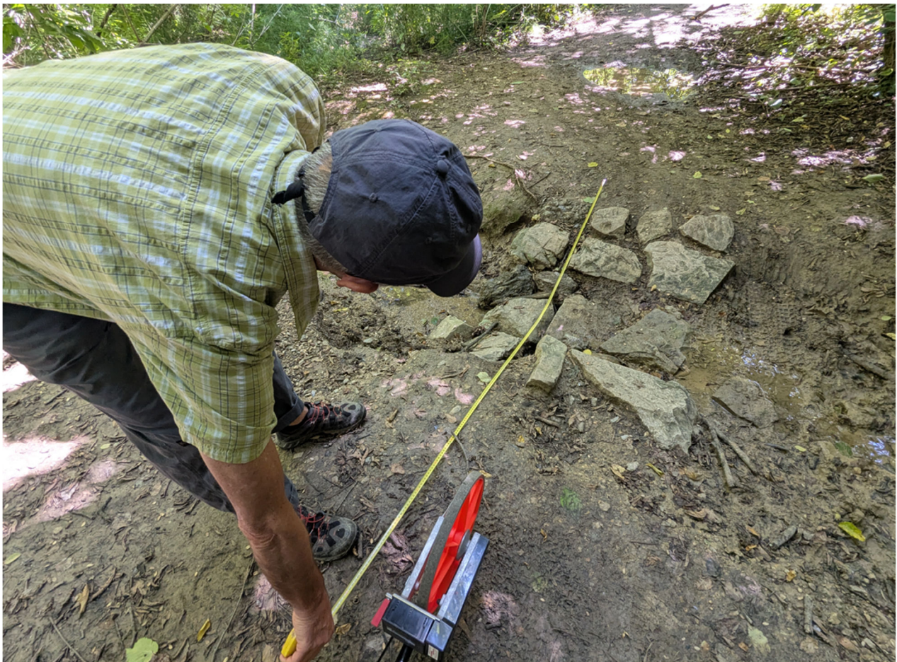
Foto 13 – Progressiva 300,0m attraversamento con basto in pietra
