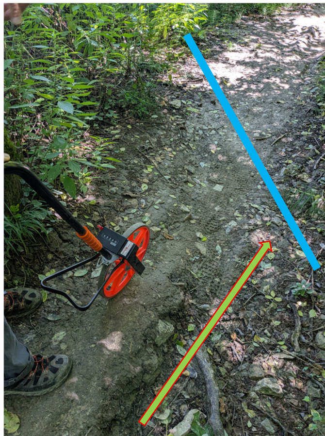
Foto 14 – Progressiva 333,0m = progetto: fine gradini in destra sentiero + basto longitudinale
