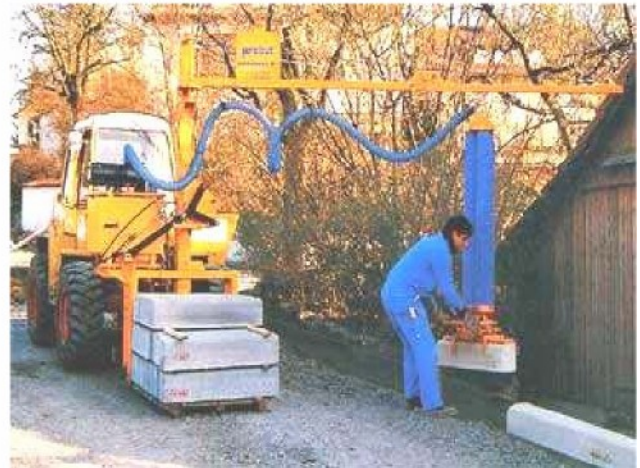
IMPIEGO MACCHINA POSA CORDOLI
