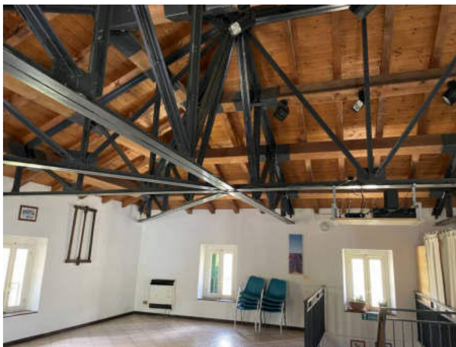
Foto 19 Sala polifunzionale piano secondo
