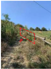
8. Ripristino sedime del sentiero, mediante realizzazione di scalini in legno e sistemazione staccionata
