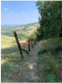
1. Ripristino sedime del sentiero, mediante realizzazione di scalini in legno
