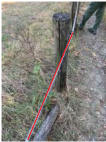
2. Realizzazione nuova staccionata
