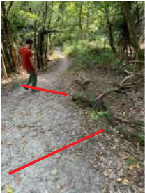
10. Ripristino sedime del sentiero, mediante realizzazione di scalini in legno e costruzione basto rovescio in legno
