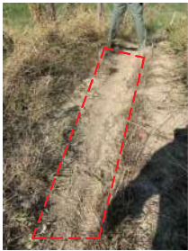
5. Ripristino sedime del sentiero, mediante l'eliminazione del solco scavato dall'acqua e operando un intervento di livellamento del terreno
