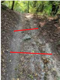
11. Ripristino sedime del sentiero, mediante realizzazione di scalini in legno e costruzione basto rovescio in legno
