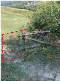
9. Posa nuova staccionata interrotta
