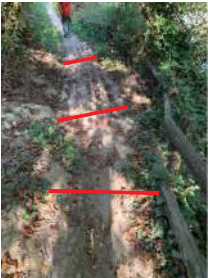
12. Ripristino sedime del sentiero, mediante sistemazione del fondo, realizzazione di scalini in legno e costruzione basto rovescio in legno
