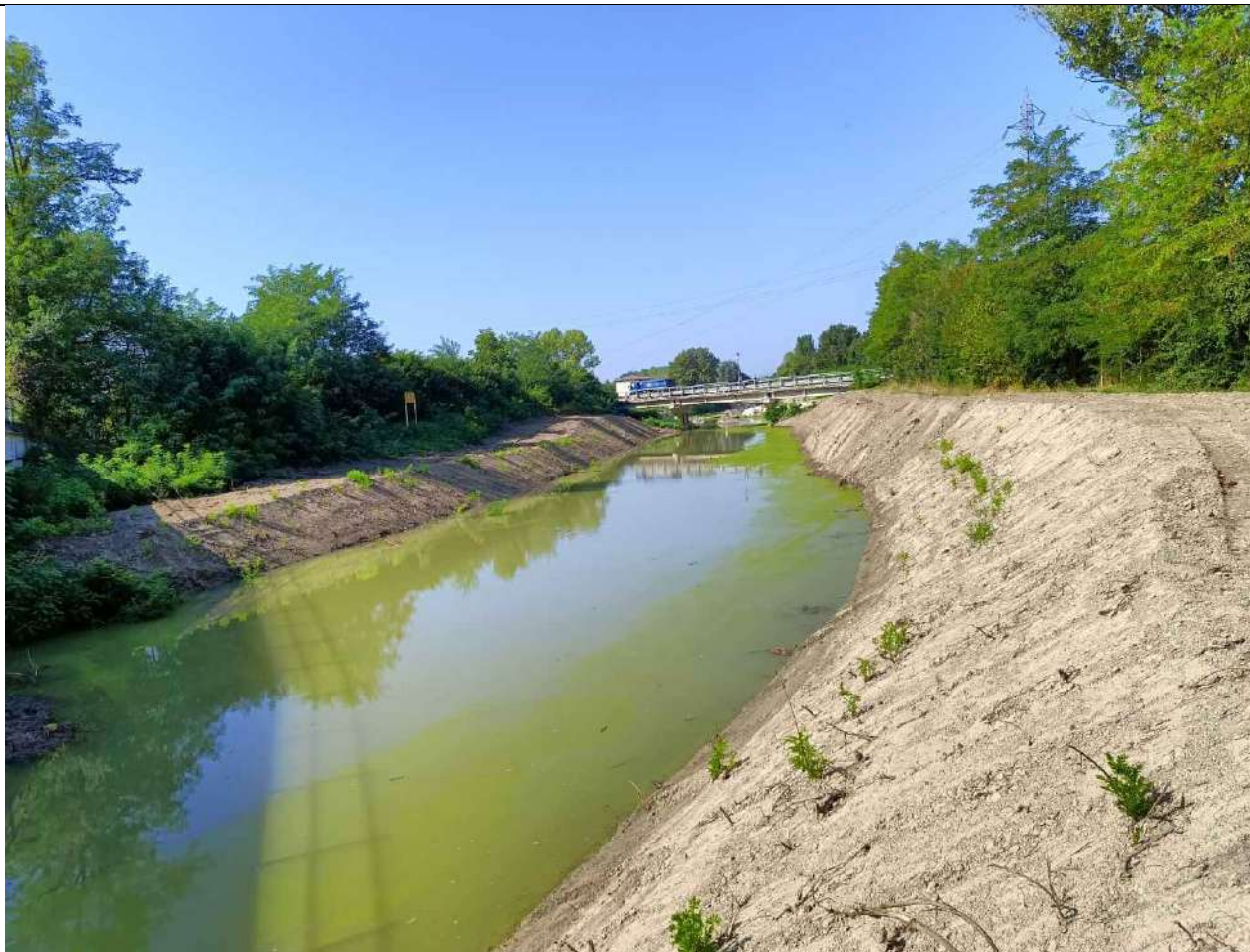
I lavori di sistemazione delle sponde del Torrente Tresinaro tra il ponte ferroviario e il ponte stradale della SP 51 nel corso del 2024.
