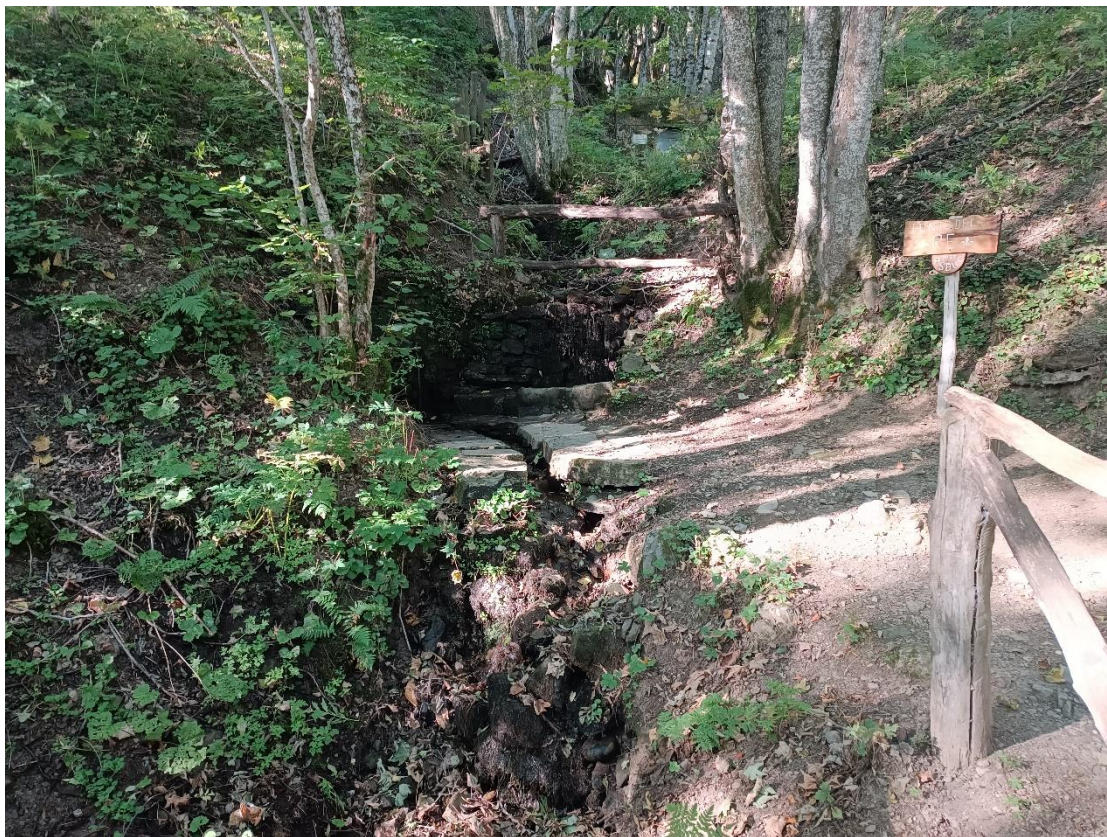
Foto 1: Vista generale dell' area di intervento dalla viabilità principale
