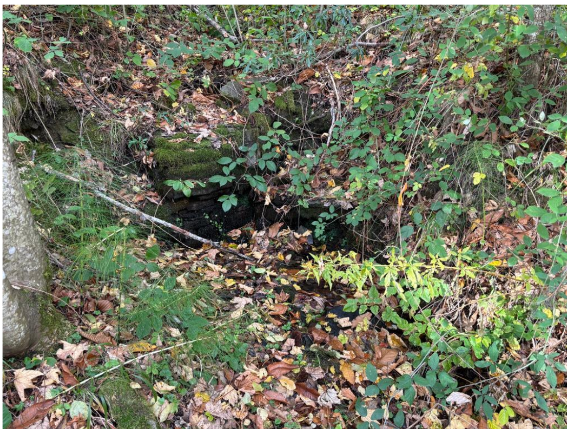
Foto 6: Stato attuale dei luoghi, evidente la necessità del recupero delle murature esistenti
