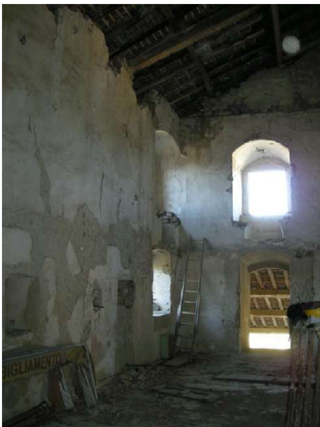
28- Interno piano superiore
