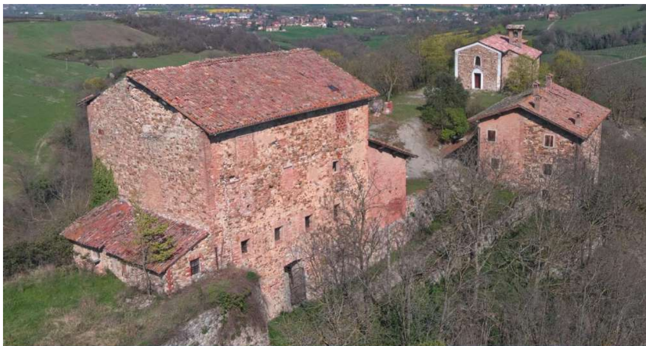
3 -Vista del complesso da sud-ovest
