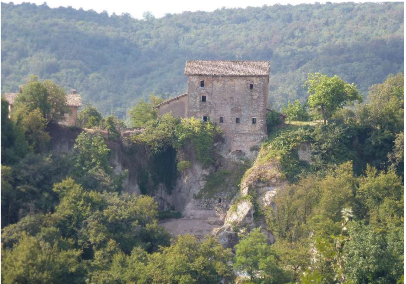
2 -Vista del complesso da nord
