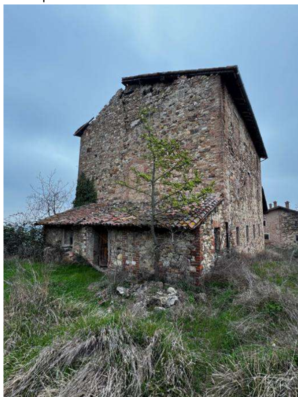
15 -Vista del prospetto ovest del Castello
