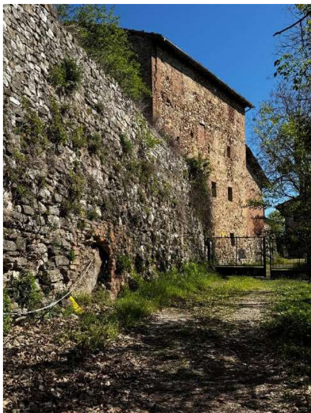
10 - Accesso al Castello da ovest
