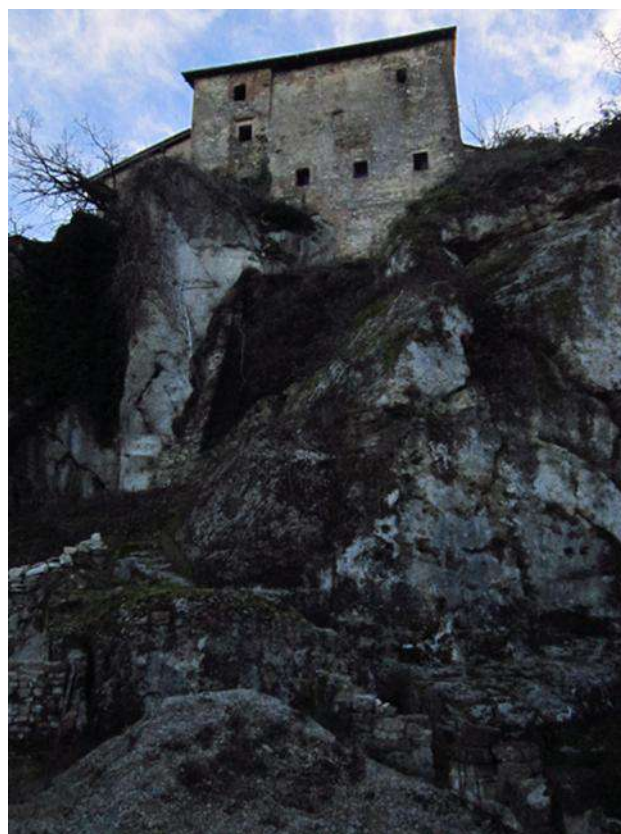
14 -Vista prospetto nord del Castello
