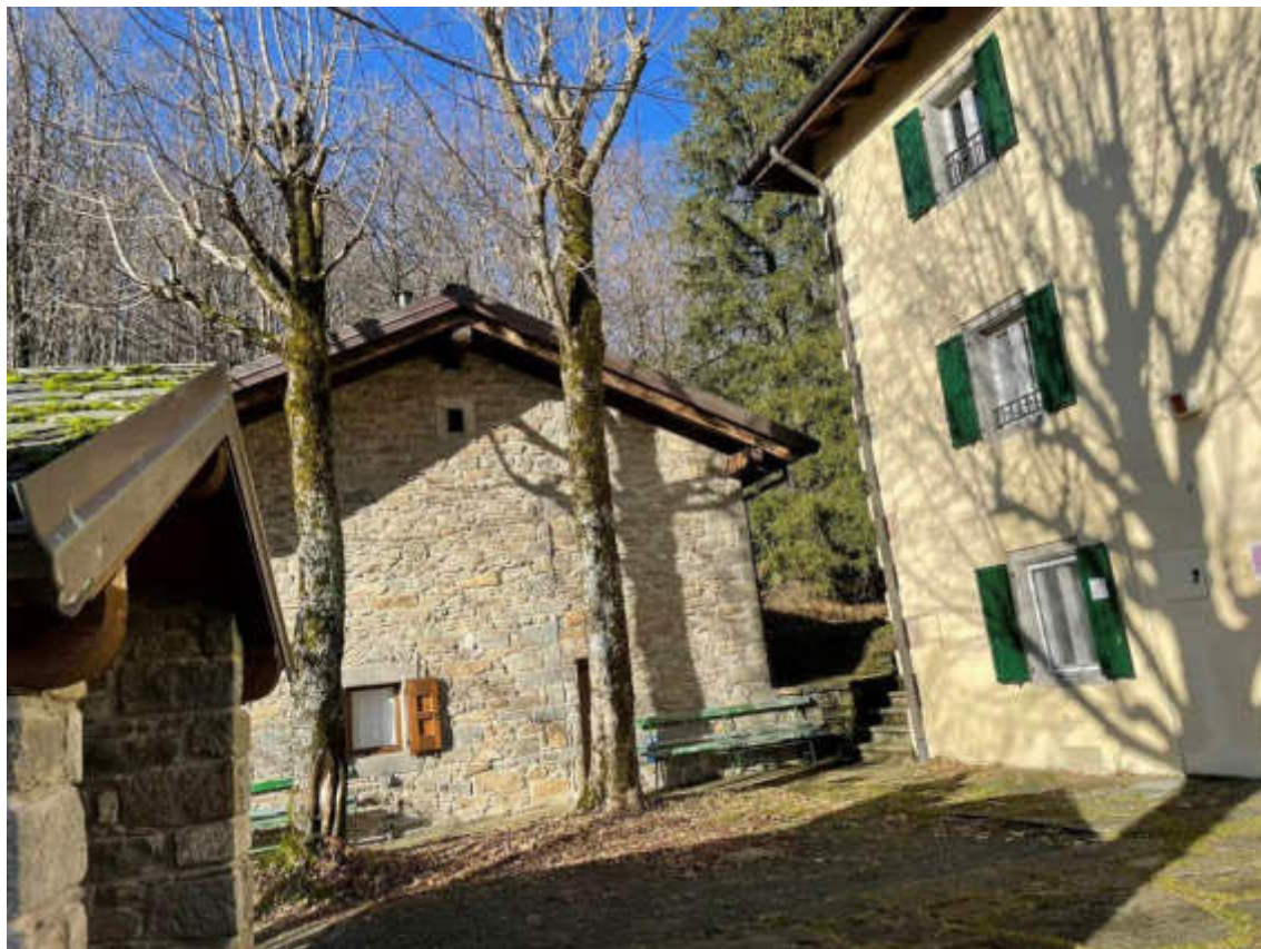
Immagine 09 – Foto edificio A oggetto di intervento e pertinenza B in sasso
