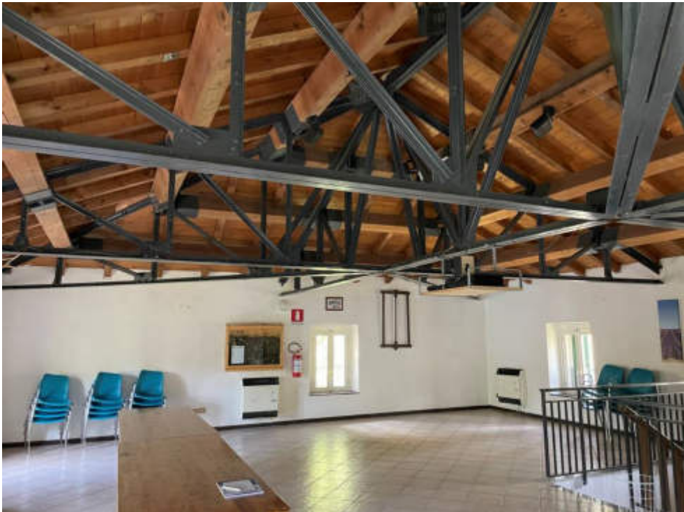
Foto 09 - Sala polifunzionale piano secondo
