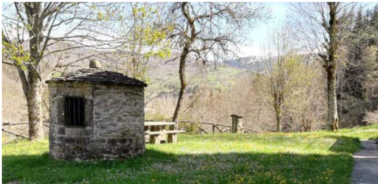
Immagine 07 – Foto area esterna con pozzo F in sasso
