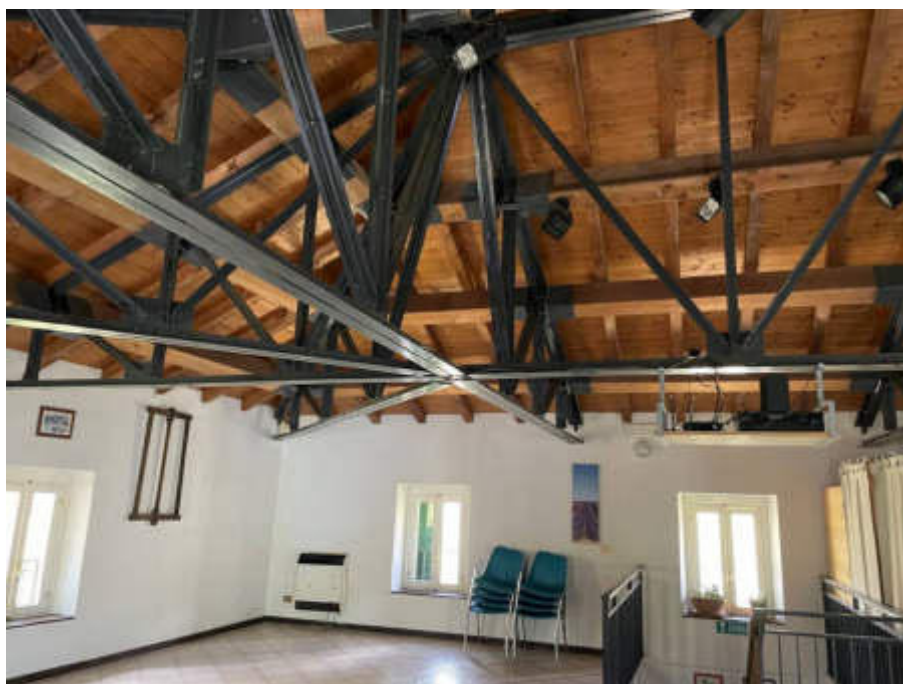
Foto 19 Sala polifunzionale piano secondo
