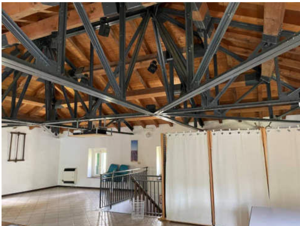
Foto 16 – Sala polifunzionale piano secondo
